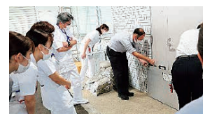
止水板設置の様子
