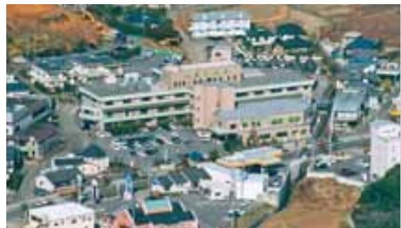
平成10年東外来棟増築
